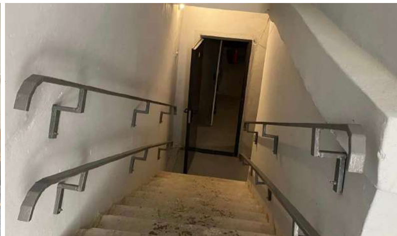
Відремонтовані сходи в укриття закладу освіти, Сумська область
