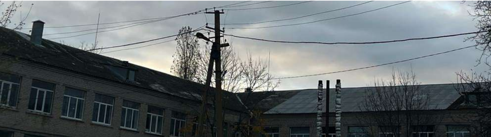
Відремонтований дах у закладі освіти, Миколаївська область
