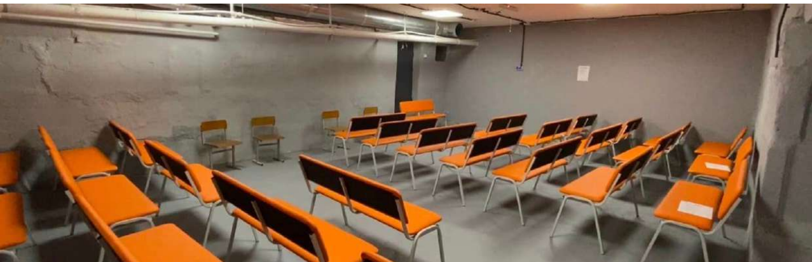
Відремонтване укриття, Сумська область
